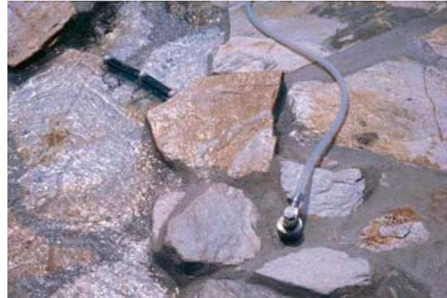
Drehbarer Schlauchanschluß und Schleusen
