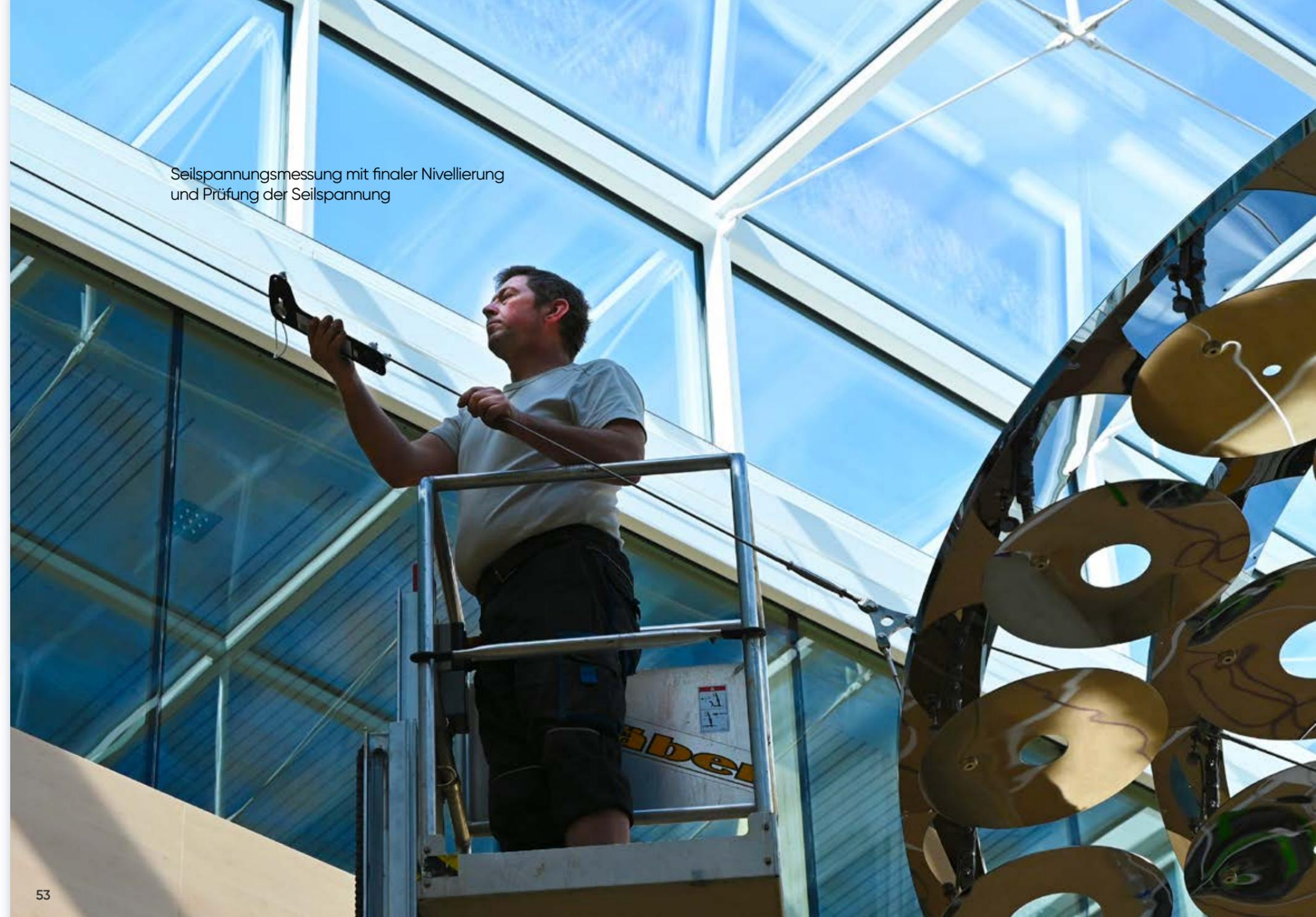
Seilspannungsmessung mit finaler Nivellierung und Prüfung der Seilspannung
