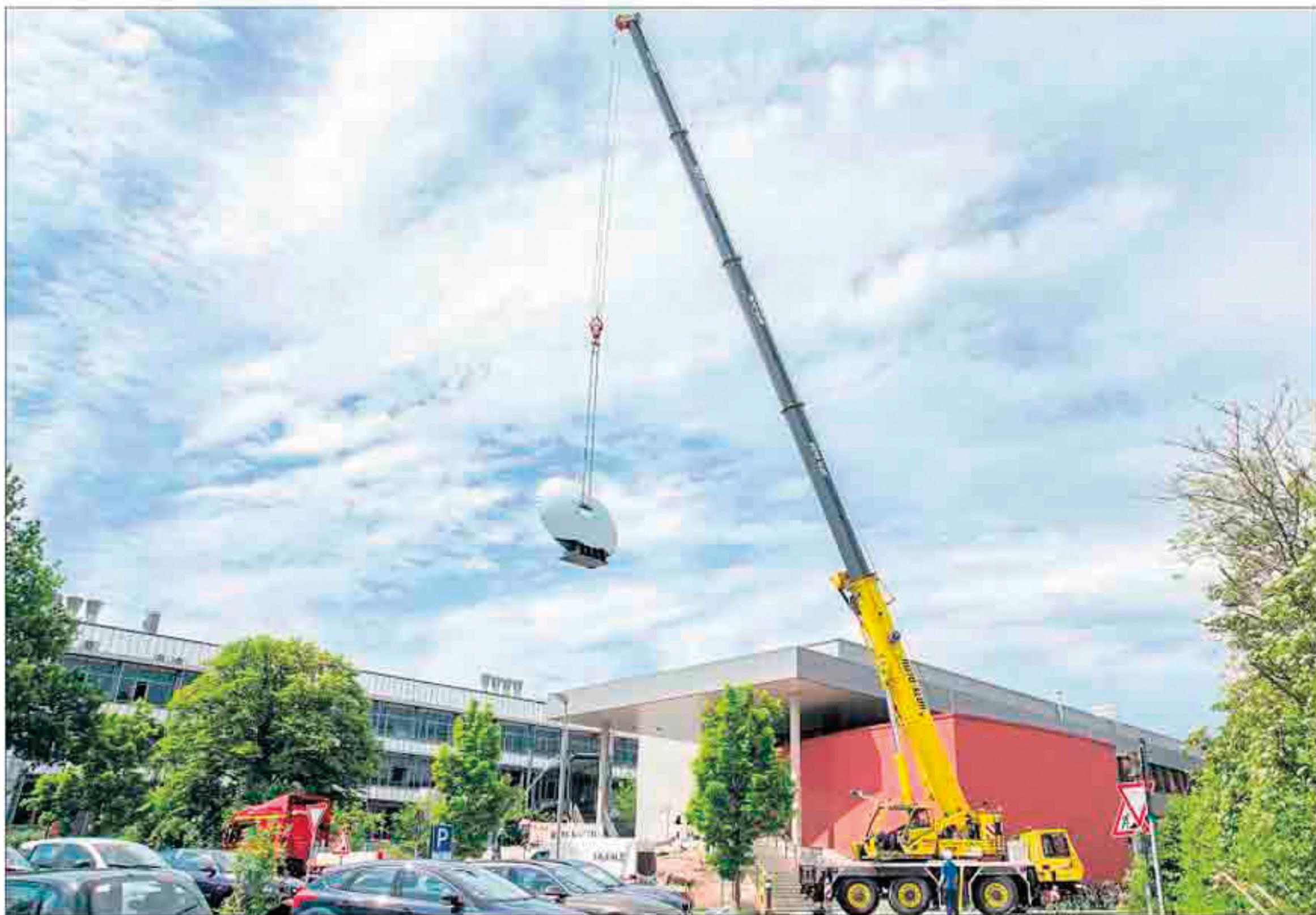
Vor dem Eingang zum Gebäude NW III wird die Arbeit „you are free“ des unterfränkischen Künstlers Robert Kessler installiert. Den Anfang machte ein 3,50 Meter hoher Edelstahlspiegel, der mit Hilfe eines Krans auf sein Podest gehoben wurde.
